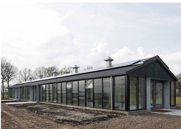
Renovatie - Kiemschuur Frederiksoord 2012
