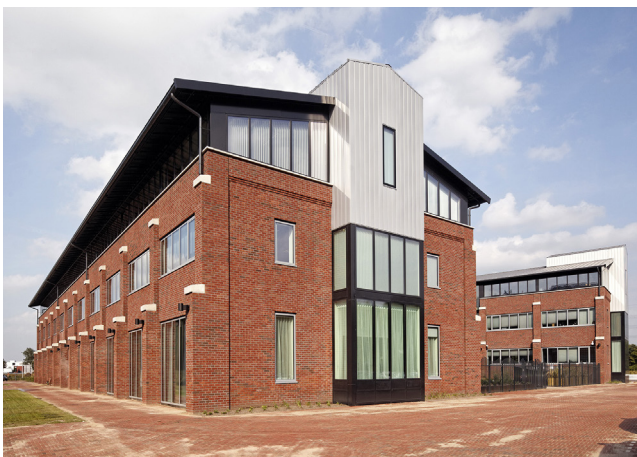
Kantoorpand - Agrifirm Apeldoorn 2013
