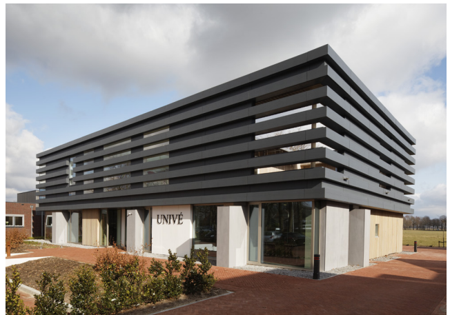
Kantoorpand - Unive Dwingeloo 2013
