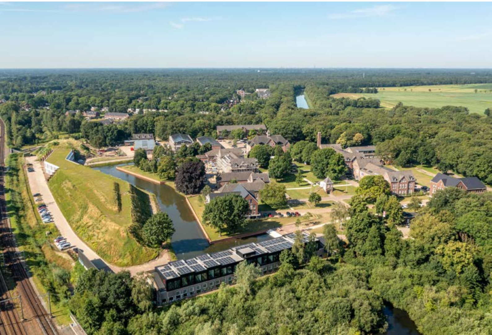
Overzichtsfoto vanuit het noorden van Fort Isabella met rechts van het midden het groene Isbellplein met logiesgebouwen en daarvoor de twee poortgebouwen van de 'Isbellapoort' die de hoofdentree markeren (foto: Boomkwekerij Ebben, René Post)
