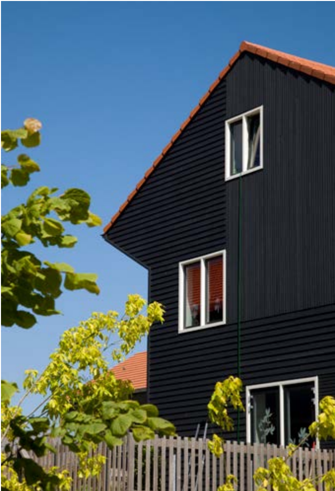
Foto van de gevelaanzichten, materialen, kleuren en zorgvuldige detaillering (foto: Sjaak Henselmans)
