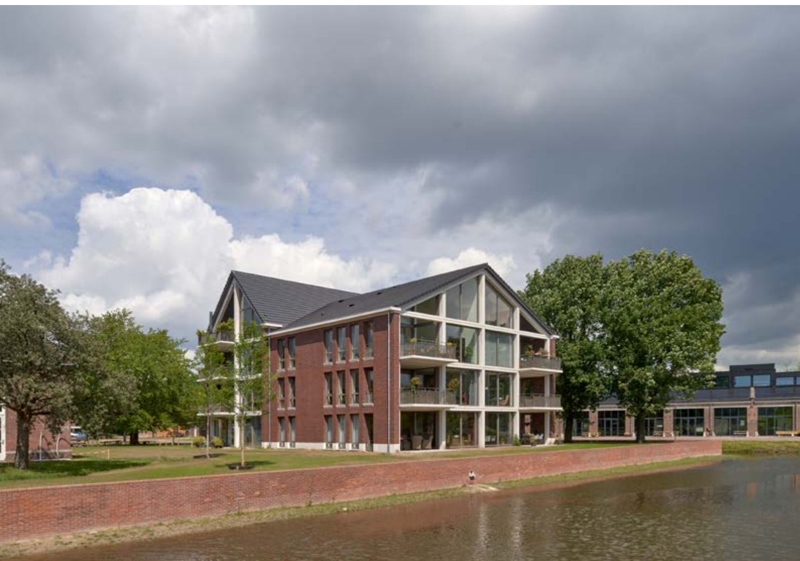
Foto van het oostelijke poortgebouw 'Isabellapoort' met gecoupeerde gevels met balkons die zich openen naar de meer informele zijden van de het kazerneterrein met op de voorgrond de weer open gegraven gracht met keermuur die de schans markeert (foto: HILBERINKBOSCH architecten, René de Wit)
