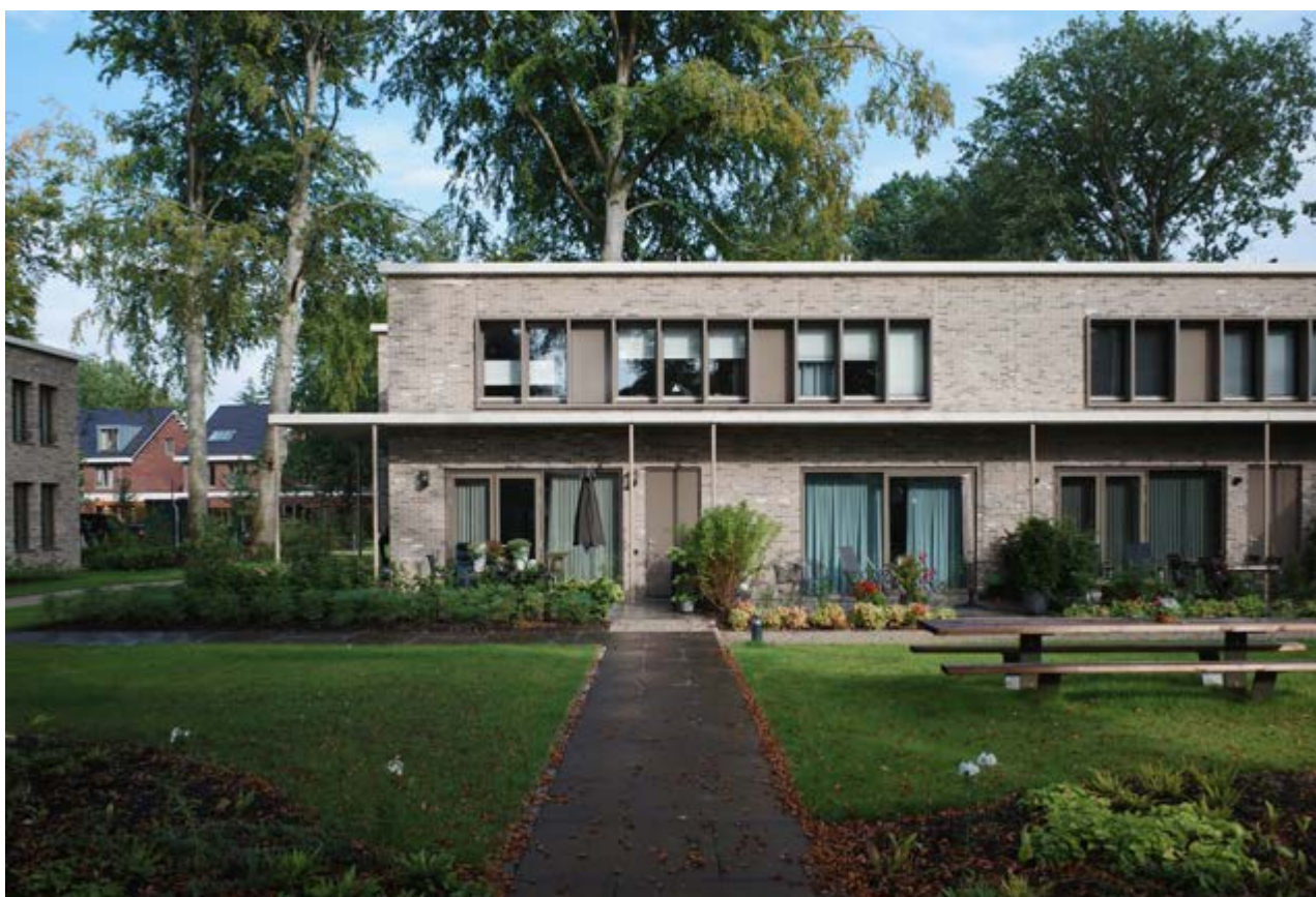
Het gevelaanzicht van de terraswoningen aan tuinhoven heeft een open en horizontaal karakter. Door de grote openingen en veranda's kunnen bewoners in de geest van het sanatorium genieten van 'licht, lucht en natuur' (foto: archief Diederendirix Architecten)
