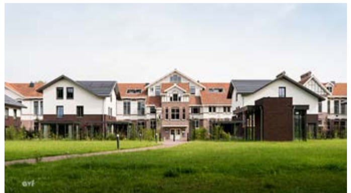
Het ensemble vanaf het met gras begroeide dek van de parkeergarage met rechts van het midden de voetgangsentree naar de garage en daarachter de villa's en het paviljoen met bakstenen onderbouw en witte verdiepingen (foto: Braaksma & Roos Architectenbureau)
