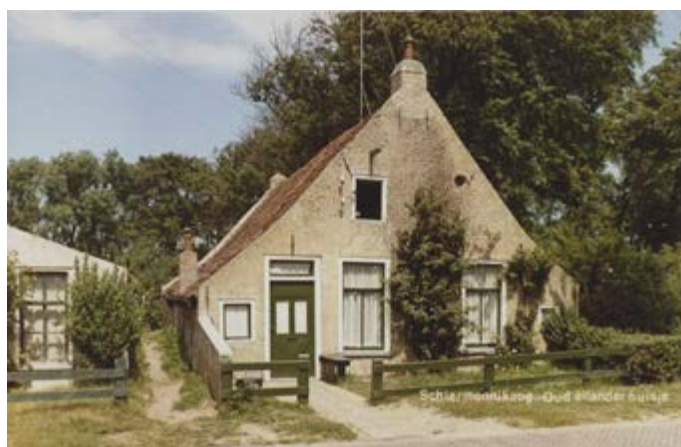
Ansichtkaart met een oud eilanderhuisje met kenmerkende licht asymmetrische hoofdvorm met een zaagtandgevel met een schoorsteen als bekroning en kenmerkende erfscheidingen in de vorm van schuin aflopende muurtjes, hagen en een eenvoudige houten omheining (foto: website www.theerenfeer.com )
