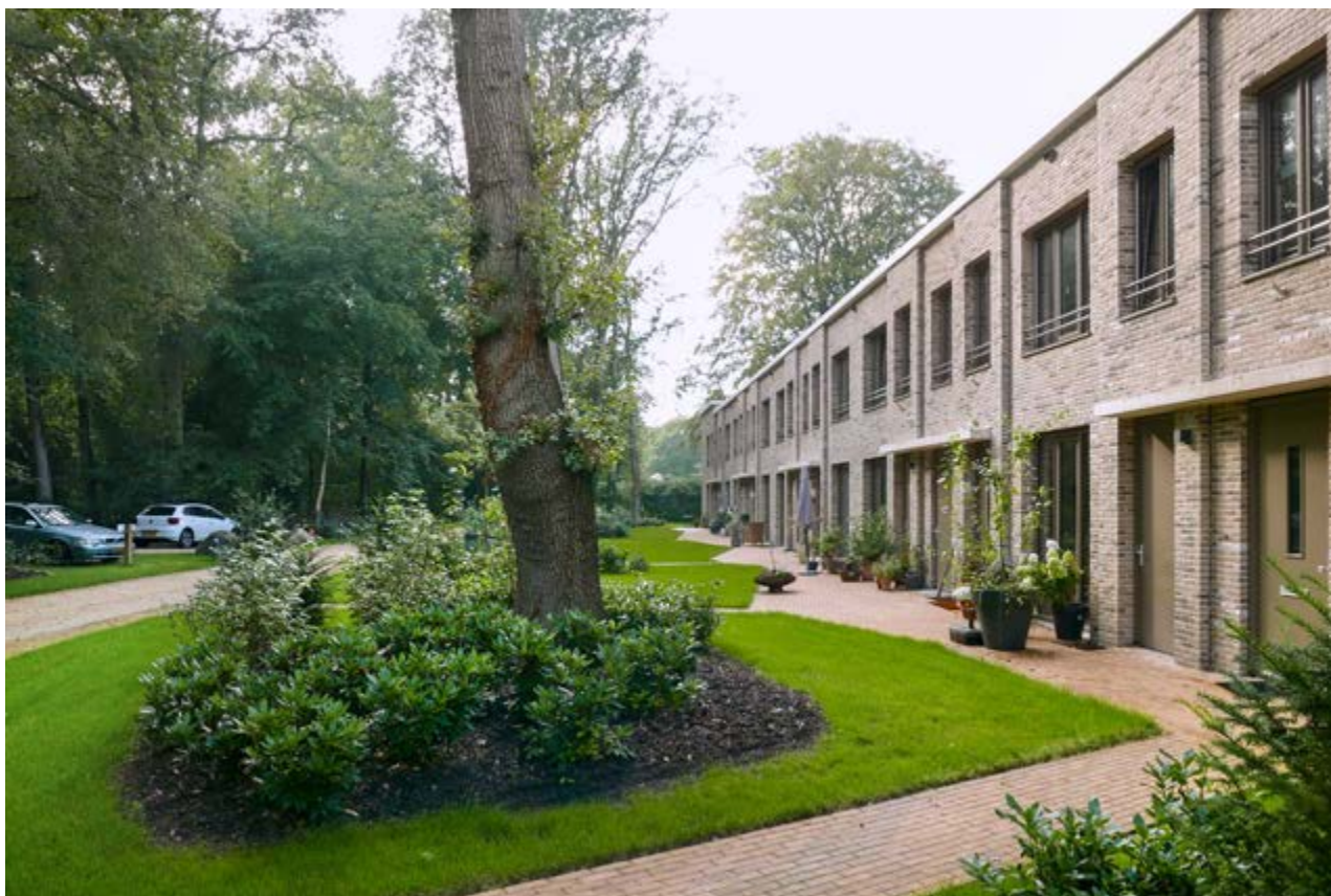
Het gevelaanzicht van de terraswoningen aan de zijde van de bosrand heeft overwegend een gesloten en verticaal karakter. De overgang naar de woning bestaat uit een stoep met een gevarieerde breedte en een luifel bij de entree (foto: Archief Diederendirix Architecten)
