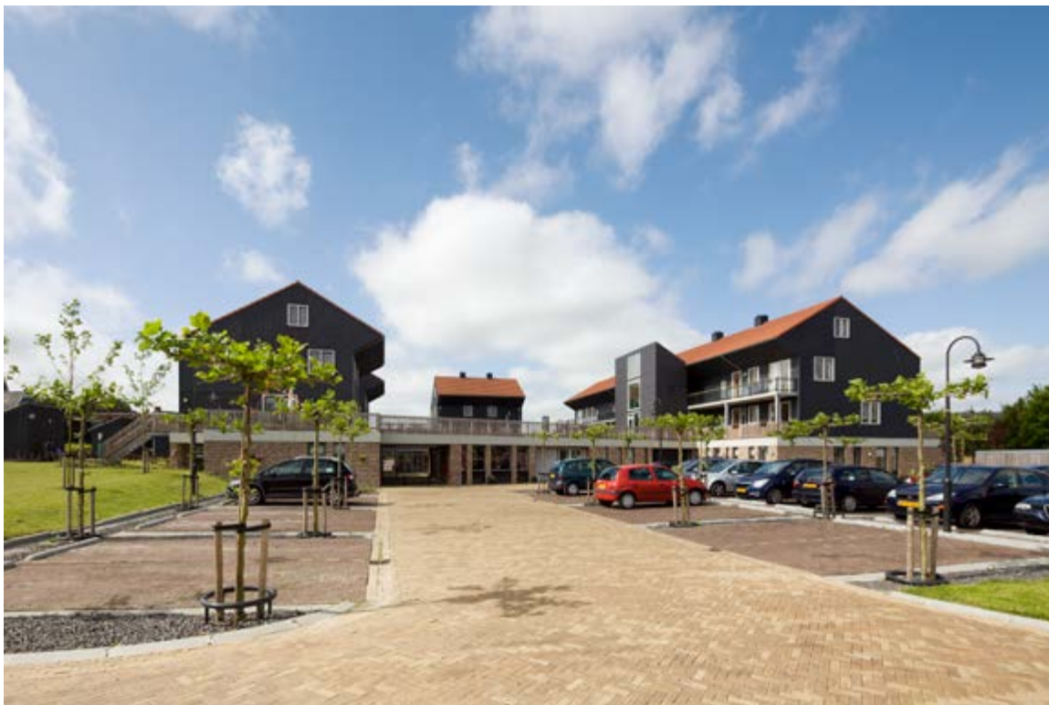
Foto vanaf het Spokepad met zicht op het entreegebied van het woongebouw met parkeerplaatsen en tussen de auto's ruimte voor dakplatanen (foto: Sjaak Henselmans)
