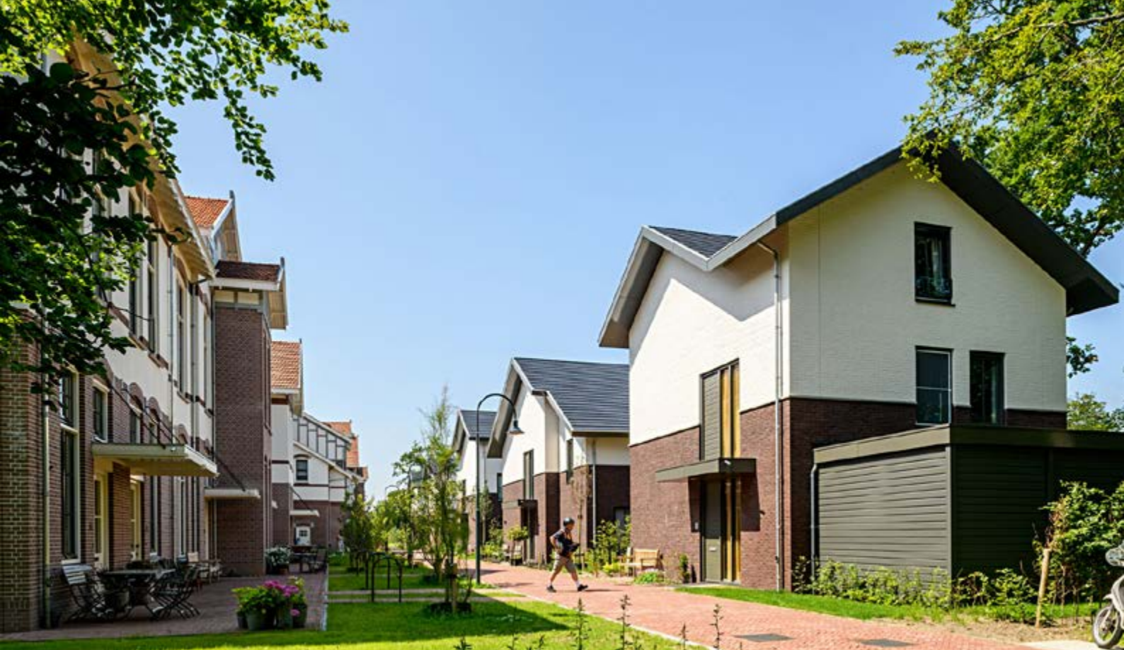
Het groen ingerichte straatje tussen het paviljoen en de nieuwe villa's met gevelsprongetjes en een flauw hellend (samengesteld) dak met overstekken respectievelijk links en rechts in het beeld (foto: Braaksma & Roos Architectenbureau)
