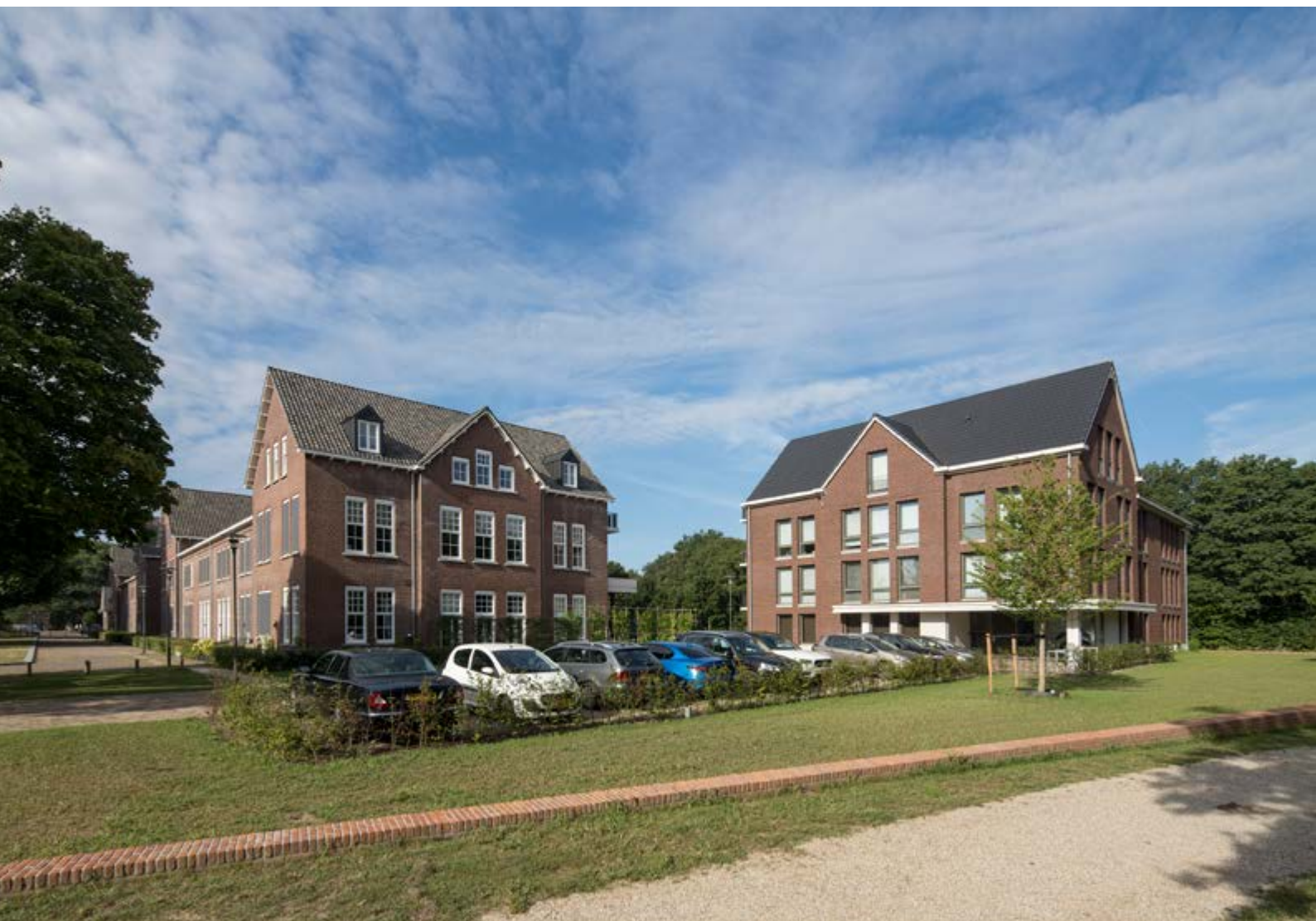
Foto van het westelijke poortgebouw van de 'Isabellapoort' dat op een eigentijdse wijze de verbinding zoekt met de logiesgebouwen met op de voorgrond het bakstenen muurtje dat de schans markeert (foto: HILBERINKBOSCH architecten, René de Wit)
