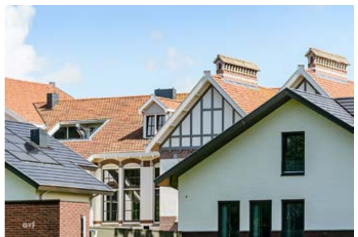
Loggia's van de appartementen zijn gesitueerd op ondergeschikte plekken aan de noordzijde van het paviljoen en bescheiden van afmetingen met op de voorgrond de villa's (foto: Braaksma & Roos Architectenbureau)
