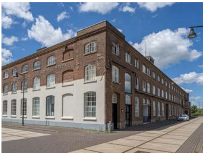
De zuid- en oostgevel van het Beltmancomplex met achter de gevels de royale huurwoningen en in het midden van de oostgevel rechts op de foto de poort naar de binnentuin (foto: Jan van Dalen)
